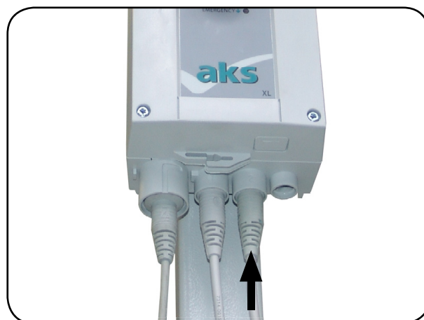
Abb. 6.1.07 - Spreizantrieb anschließen
