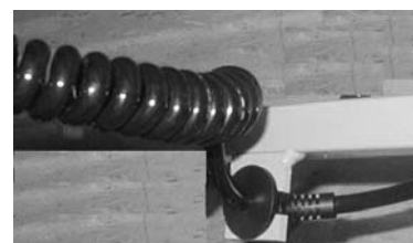
Afb. 15: Trekontlasting van de kabel voor de netaansluiting
