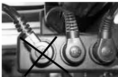
Figura 11: Conexión correcta de los motores y del mando manual
