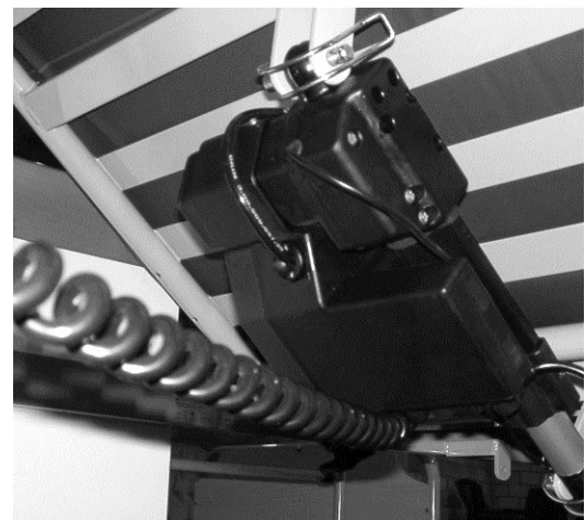
Figure 14: Pose du câble d'alimentation
