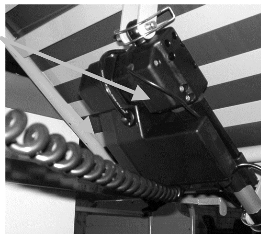
Figura 14: posa del cavo di collegamento alla rete
